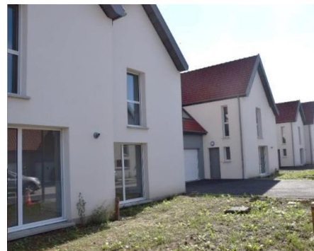
Marquise – ZAC du Canet – logements T4 livrés en juillet 2021
