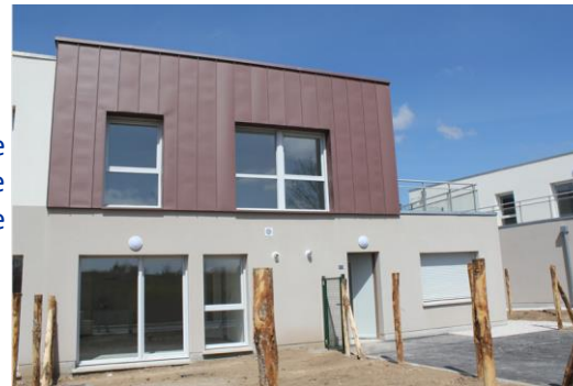
Marquise – Opération de démolition/reconstruction square Fayeulle
