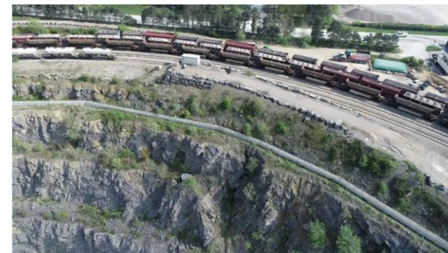
Installation ferroviaire sur la carrière de Ferques – source Les Echos
